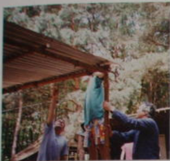
NAD STŘÍŠKOU TROUBOU JE NUTNĚ POŘÁDNĚ UPEVNIT. A TO JEŠTĚ HOŠTĚ NETUŠILI, JAK NĀM LETOS V DEŠTI POSLOVĚT.
